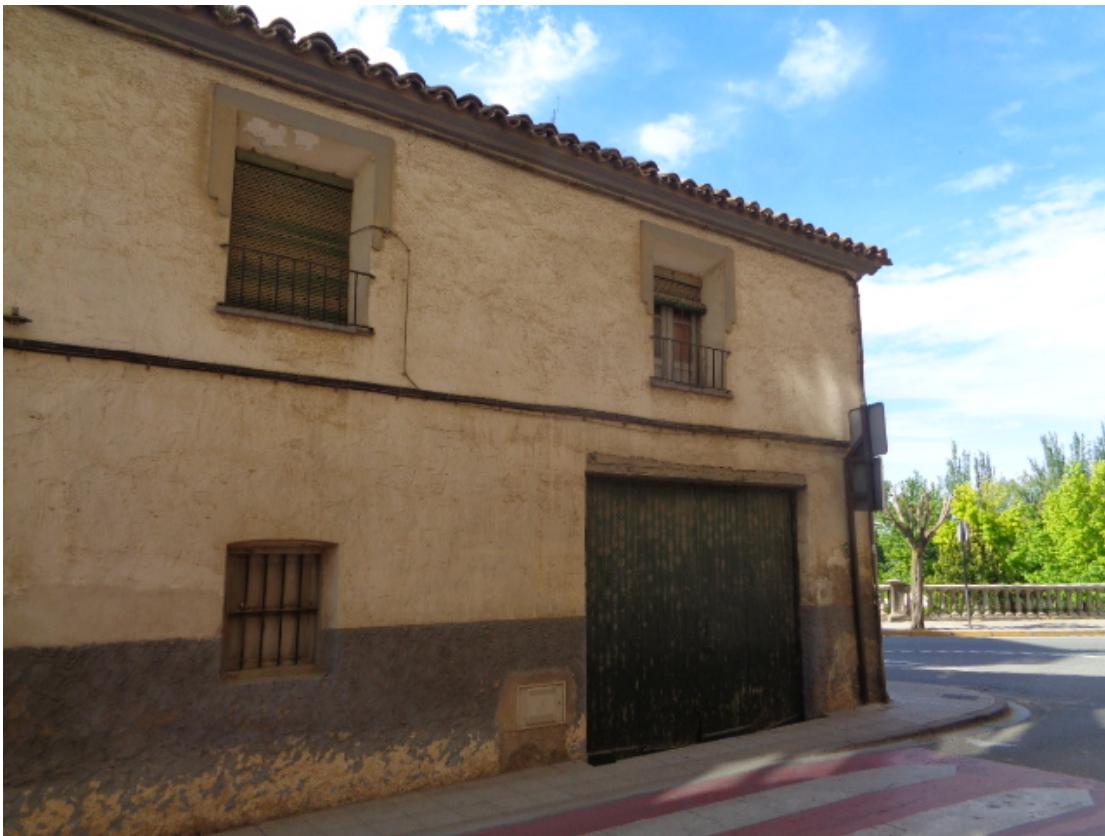
ACERA C/ TAJADAS, 19 ANTERIOR AL DERRIBO
