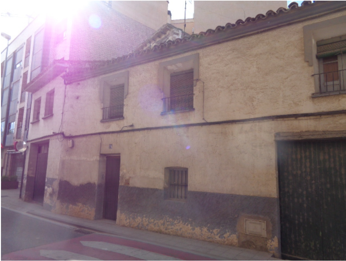
ESTRECHAMIENTO DE ACERA EN C/ TAJADAS, 19 ANTERIOR AL DERRIBO
